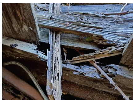
Photo n° PhTer001 Localisation : Terrasse couverte Ouvrage : Planches
