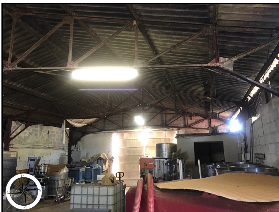
Photographie n°125. Hangar en partie Est
