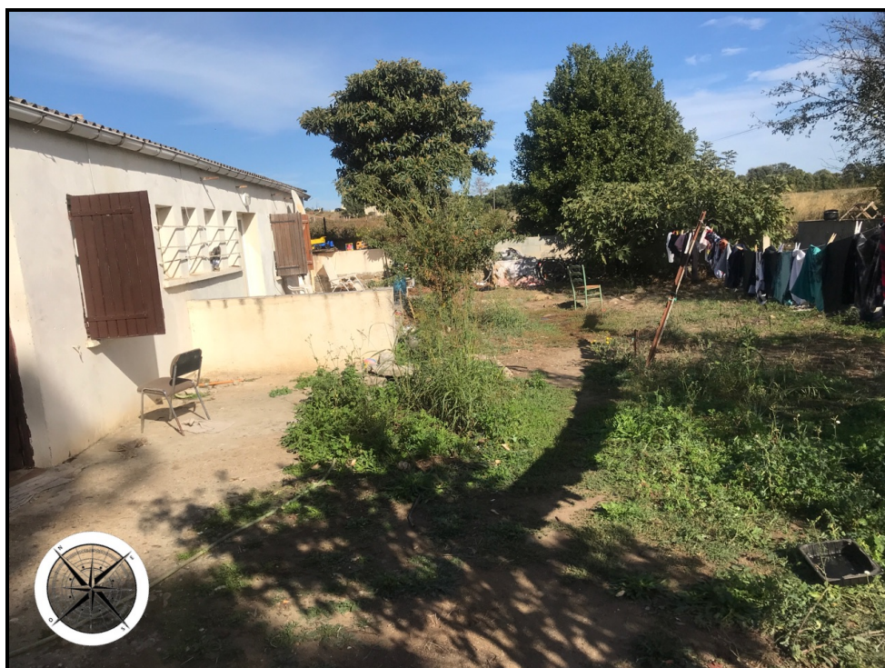
Photographie n°143. Partie Est habitable accolée au hangar sus-constaté: 2 habitations limitrophes existantes
