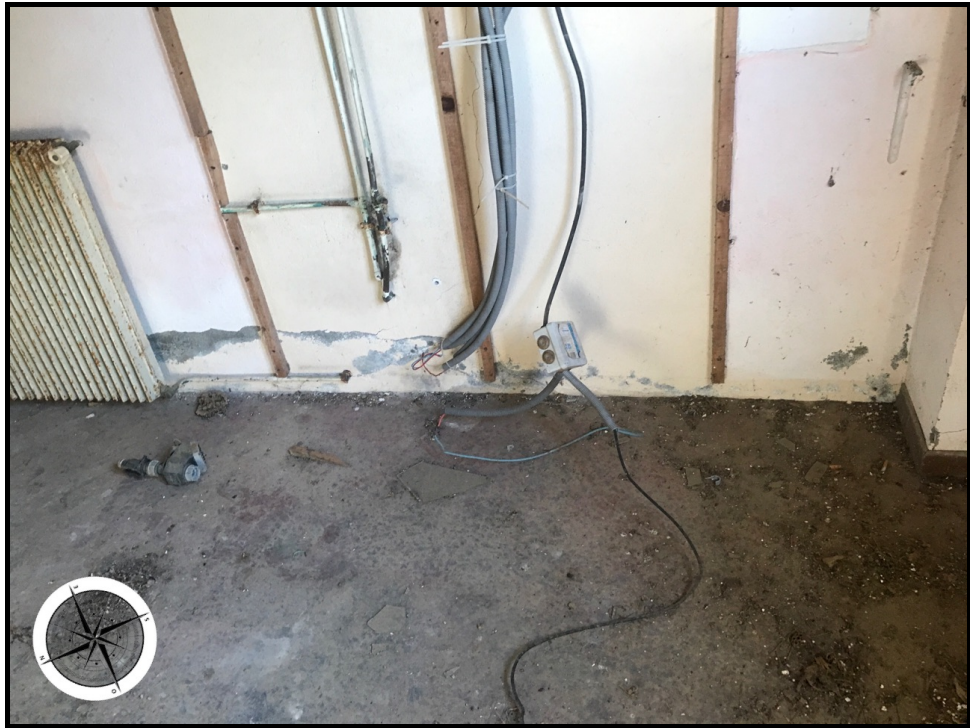
Photographie n°62. Vue générale : état du garage: fils et canalisations coupées
