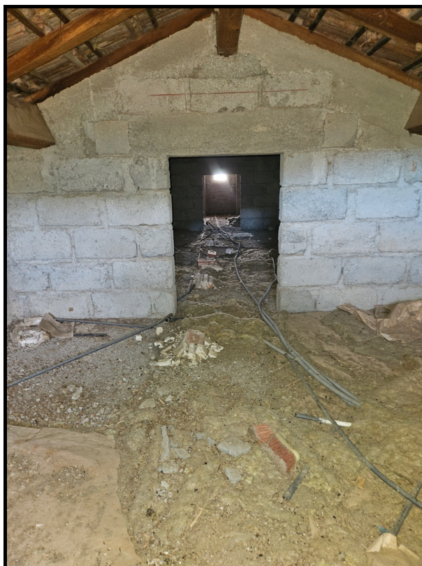
Photographie n°54. Combles: vision générale : charpente traditionnelle : état d'usage apparent
