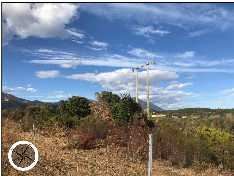
Photographie n°32. Partie vignes : côté Nord de parcelle: terrain non entretenu: présence de trace d'incendie étant survenu en Aout 2023: suite à poteau EDF défaillant (selon dires de la propriétaire saisie)
