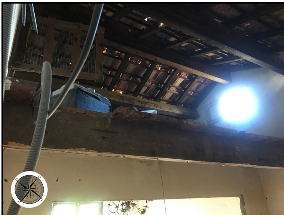
Photographie n°56. Vu generale : état du garage : vue toit: très nombreux ajouements
