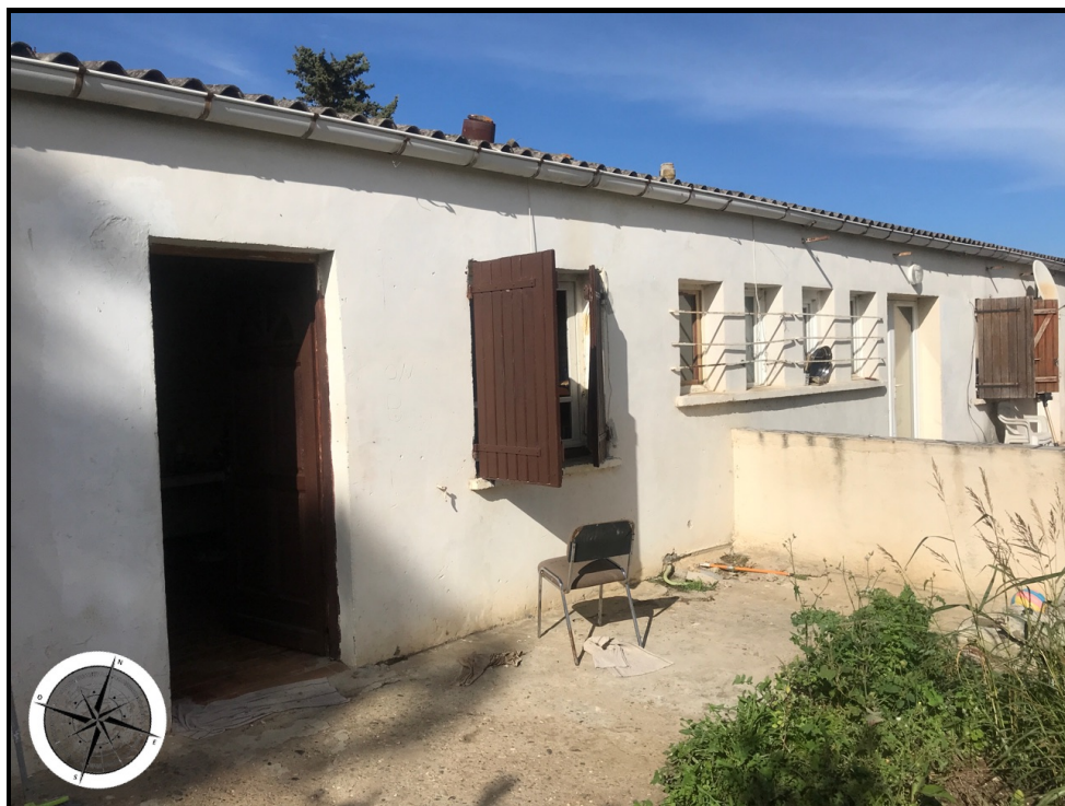
Photographie n°144. Partie Est habitable accolée au hangar sus-constaté: 2 habitations limitrophes existantes
