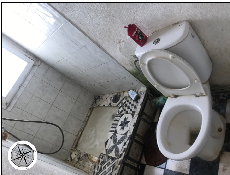
Photographie n°171. Salle d'eau et wc
