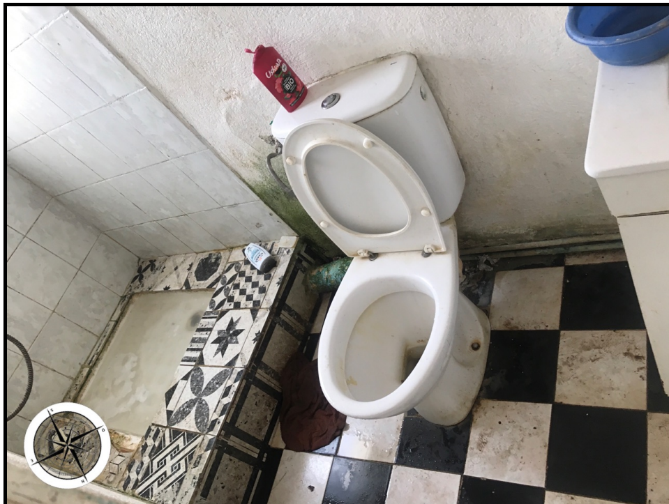
Photographie n°172. Salle d'eau et wc
