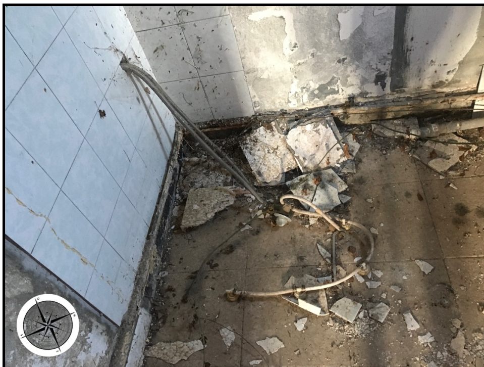
Photographie n°67. Salle bains:
