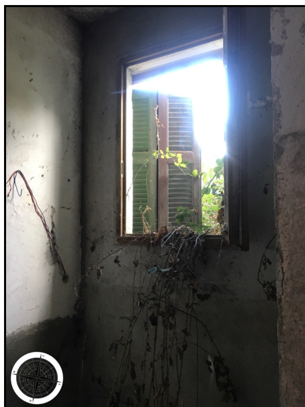
Photographie n°68. Salle bains:
