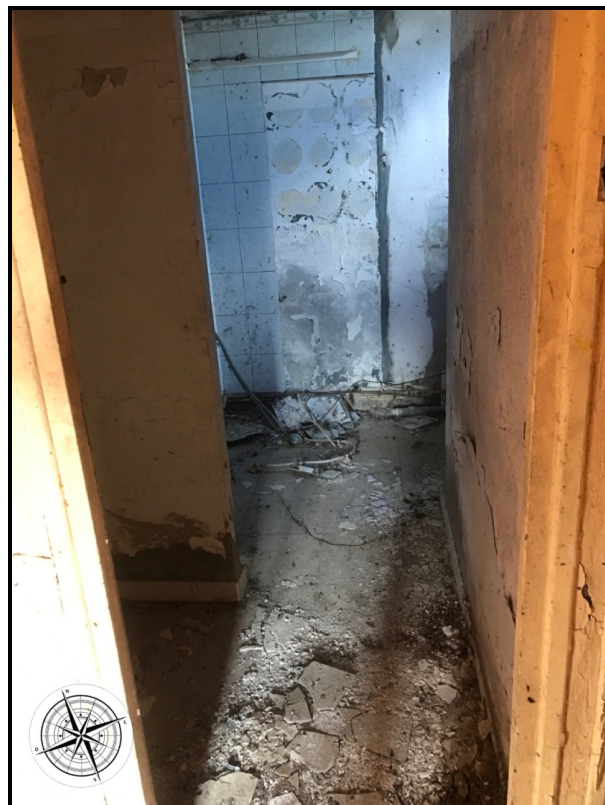
Photographie n°66. Salle bains:
