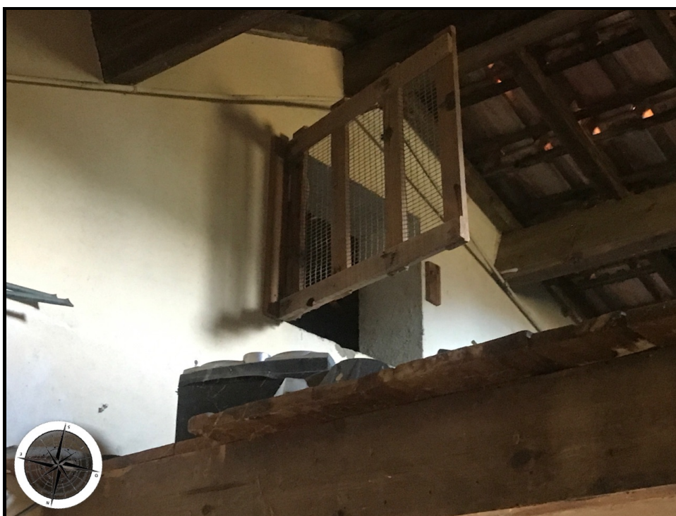
Photographie n°59. Vue générale du garage : entrée combles
