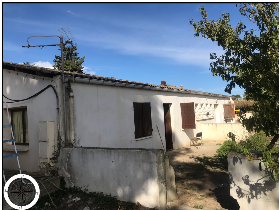
Photographie n°140. Partie Est habitable accolée au hangar sus-constaté: 2 habitations limitrophes existantes
