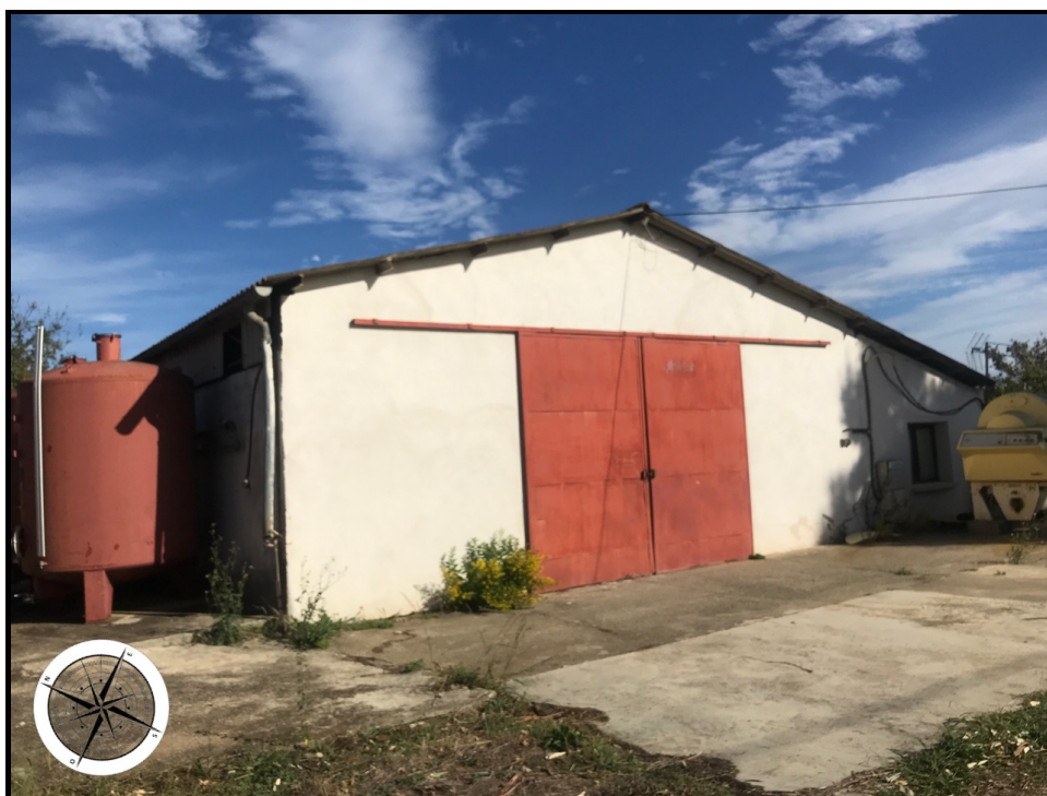
Photographie n°122. Hangar en partie Est
