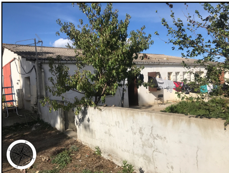
Photographie n°142. Partie Est habitable accolée au hangar sus-constaté: 2 habitations limitrophes existantes
