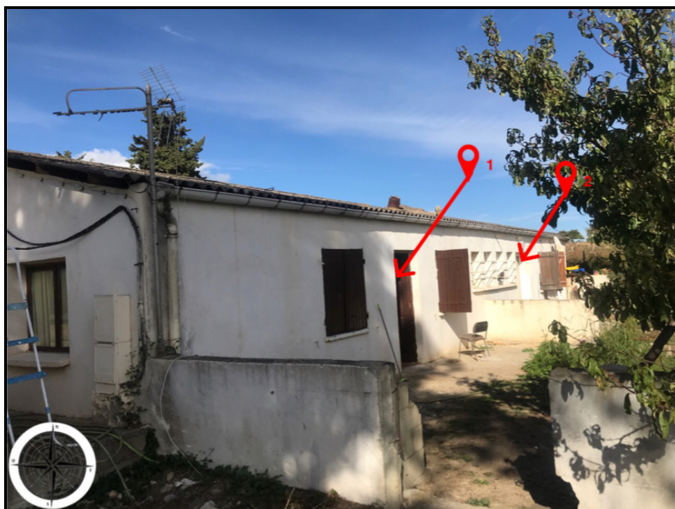
Photographie n°141. Partie Est habitable accolée au hangar sus-constaté: 2 habitations limitrophes existantes
