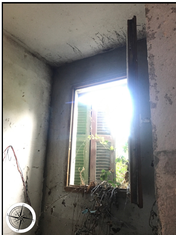
Photographie n°69. Salle bains:
