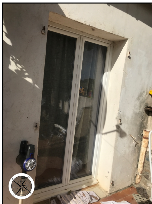
Photographie n°183. Porte d'entrée par baie vitrée PVC et double vitrage. État d'usage
