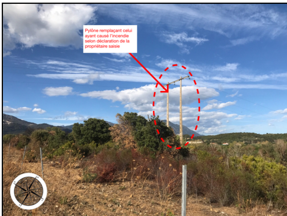
Photographie n°33. Partie vignes : côté Nord de parcelle: terrain non entretenu: présence de trace d'incendie étant survenu en Aout 2023: suite à poteau EDF défaillant (selon dires de la propriétaire saisie)
