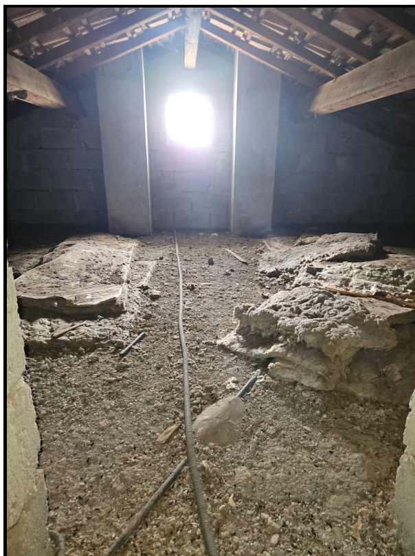
Photographie n°51. Combles: vision générale : charpente traditionnelle : état d'usage apparent
