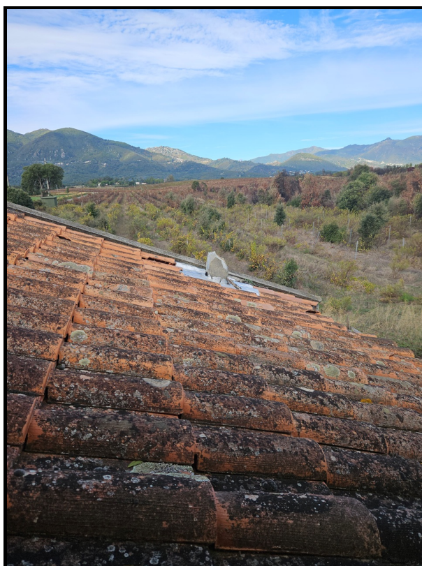
Photographie n°53. Vue des tuiles de couverture de toit et état général en vue rapprochée
