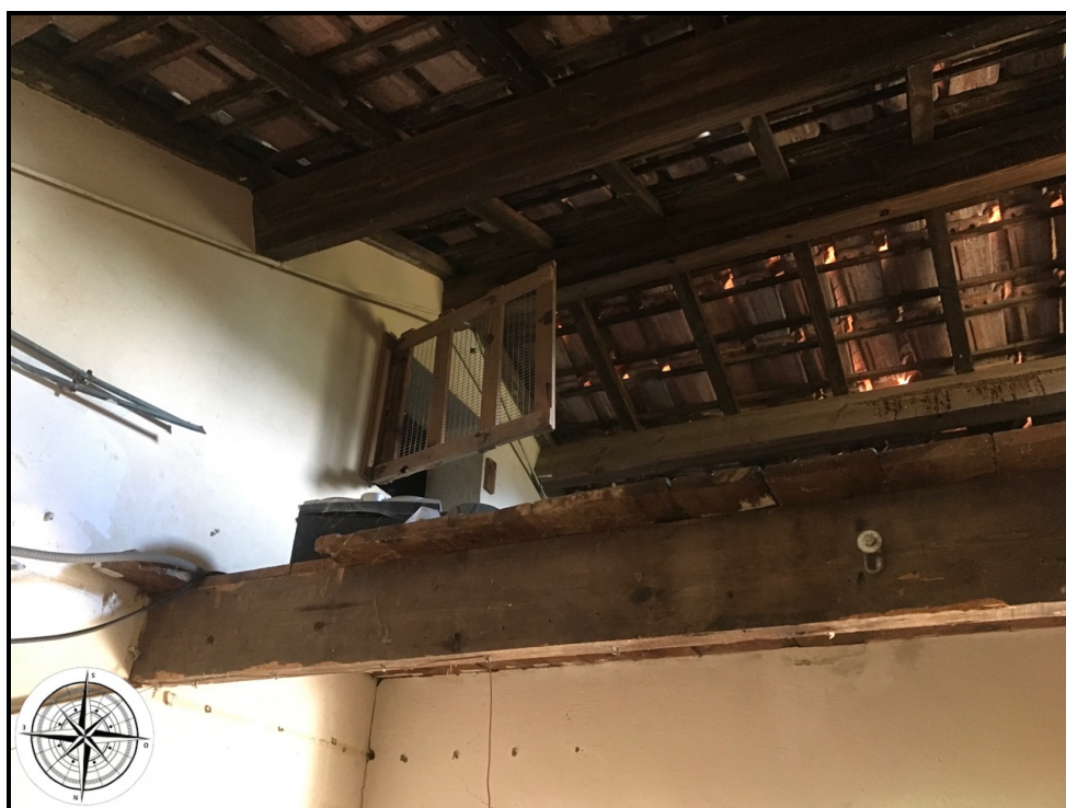
Photographie n°57. Vu generale : état du garage : vue toit: très nombreux ajouements: vue au niveau e la mezzanine et entrée sous comble
