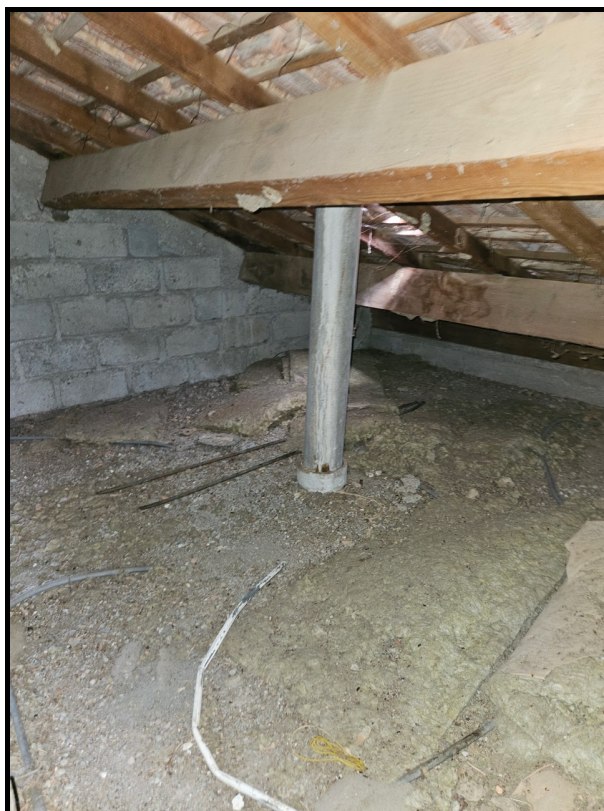
Photographie n°52. Combles: vision générale : charpente traditionnelle : état d'usage apparent
