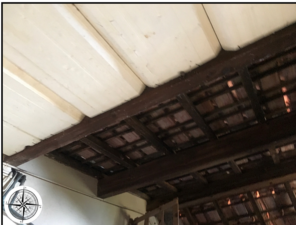
Photographie n°60. Vu generale : état du garage : vue toit: très nombreux ajouements
