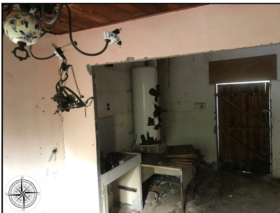
Photographie n°65. Vue générale du garage
