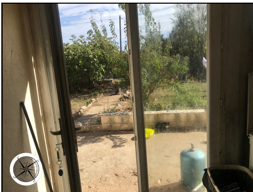
Photographie n°169. Entrée: porte-fenêtre PVC double vitrage
