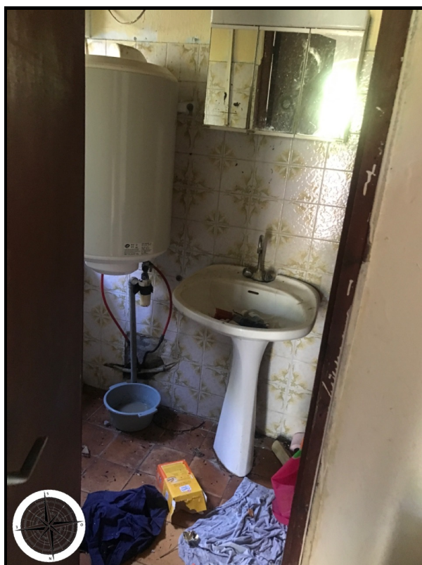
Photographie n°84. Salle d'eau
