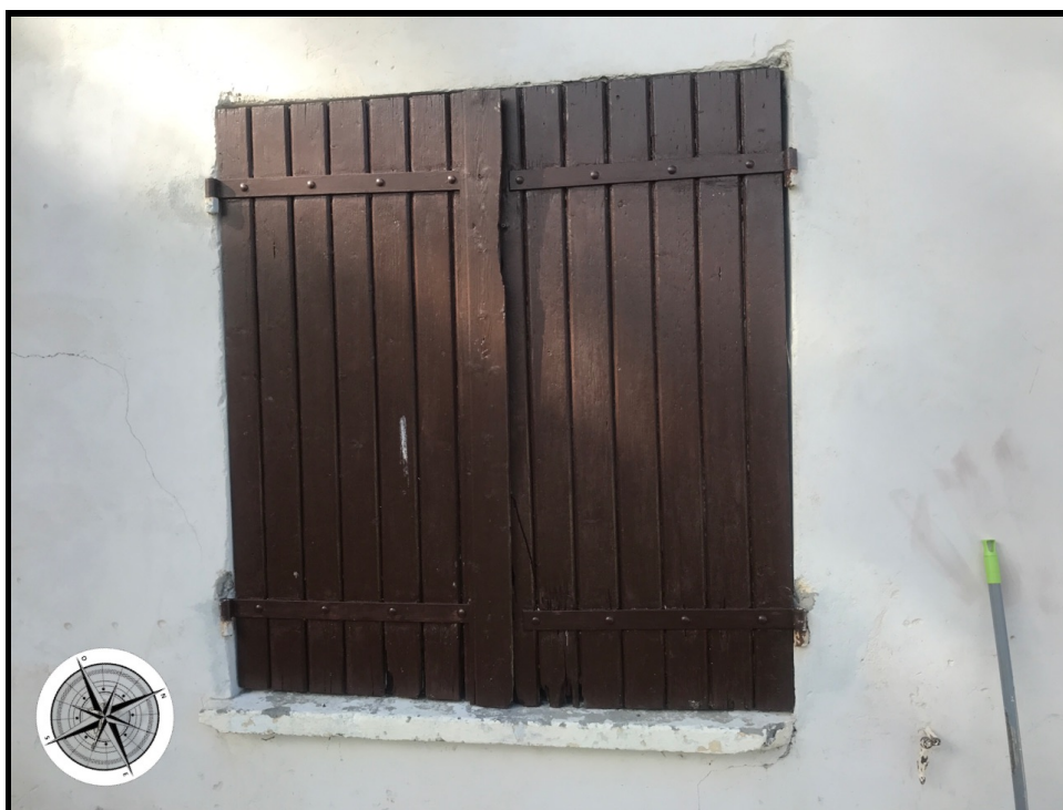
Photographie n°145. Vole5 bois extérieur à lattes
