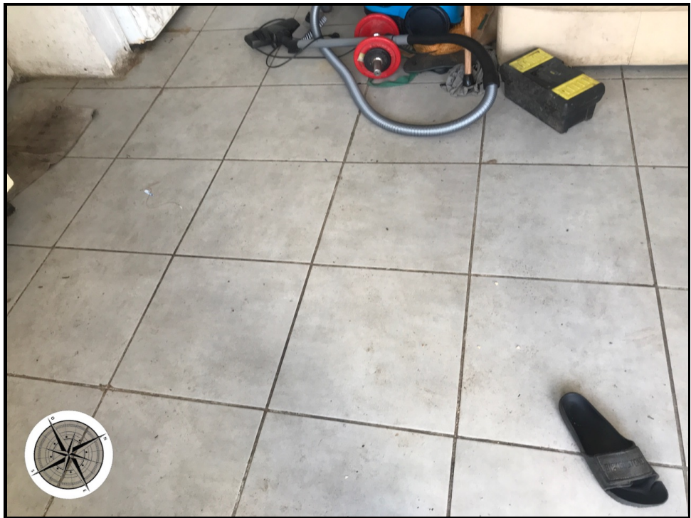
Photographie n°163. Sol carrelages
