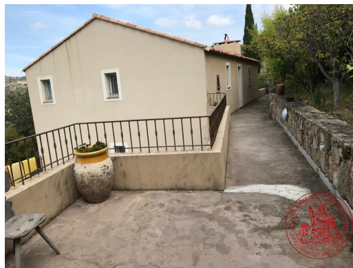
Photographie n°23. Immeuble 2: « Casa Flora »: intermédiaire
