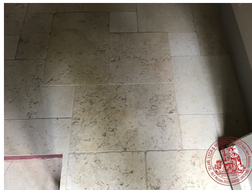
Photographie n°25. Immeuble 2: « Casa Flora »: intermédiaire: sol carrelé
