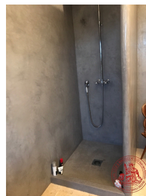
Photographie n°46. Imm. 2 R-1: Salle de bain de couloir
