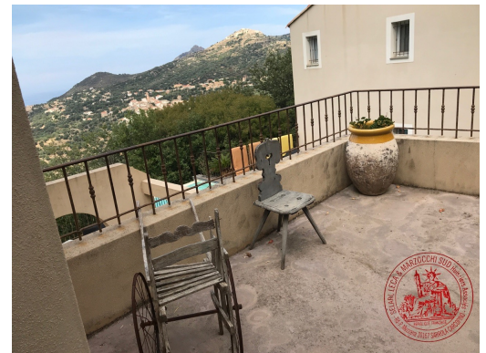
Photographie n°22. Immeuble 2: « Casa Flora »: intermédiaire
