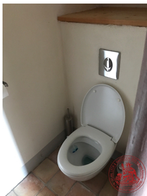
Photographie n°59. Imm. 2 R-1: Salle de bain de chambre 2: wc
