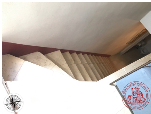
Photographie n°35. Imm.2. R-1: accès sur couloir de distribution:
