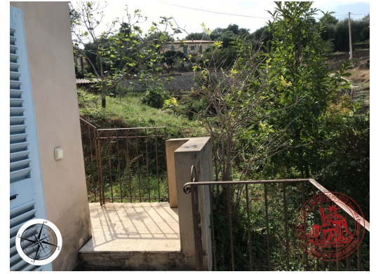
Photographie n°42. Imm2 R-1: Chambre 1: accès balcon
