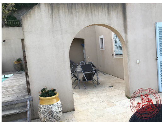
Photographie n°63. Piscine sur terrasse en partie basse Nord:
