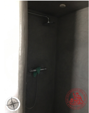
Photographie n°9. Immeuble 1: au fond d'allée: chambre isolée: Nord-Ouest: douche
