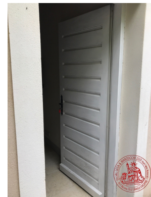
Photographie n°24. Immeuble 2: « Casa Flora »: intermédiaire: porte d'entrée
