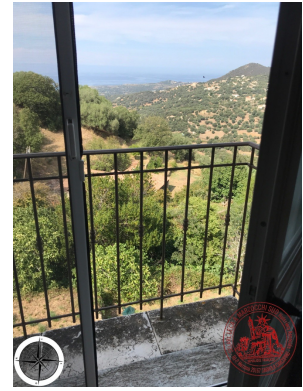
Photographie n°15. Immeuble 1: au fond d'allée: chambre isolée: Nord-Ouest: vue
