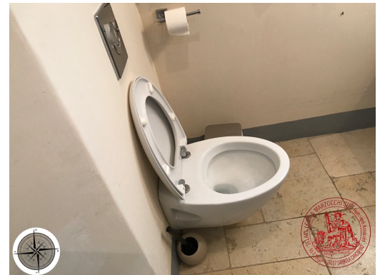
Photographie n°90. Imm3 RC Chambre 1: Espace parental:salle de bains et WC:
