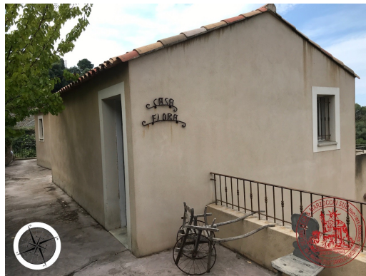
Photographie n°21. Immeuble 2: « Casa Flora »: intermédiaire
