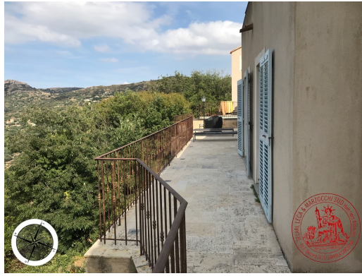
Photographie n°41. Imm2 R-1: Chambre 1: accès balcon et vue
